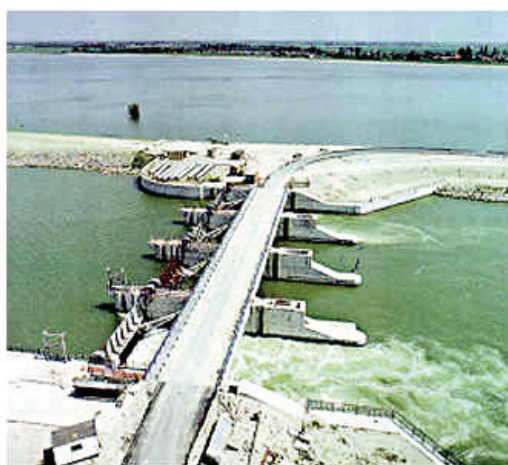
Obr. 2.3.7. Letecký pohľad na prehradenie Dunaja a hat' na obtoku (Lisický, Mucha et al., 2003).
